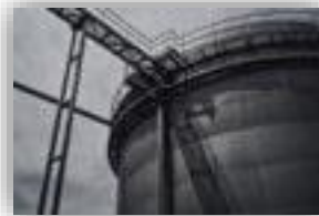
Refinerías y Plantas Químicas
